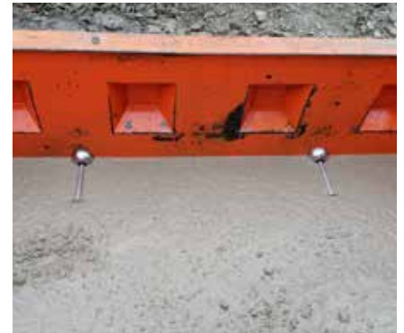
3 L'ancoraggio viene fissato all'interno del magnete, fare attenzione a vibrare il calcestruzzo
