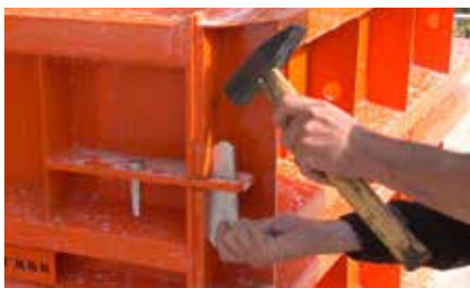
7 Rimozione di perni e cunei
