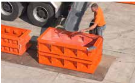
1 Posizionamento dello stampo su una piastra di acciaio
