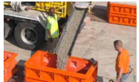
3 Gettata di calcestruzzo
