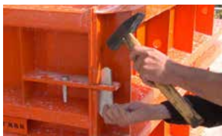
7 Retrait des goupilles et des clavettes.
