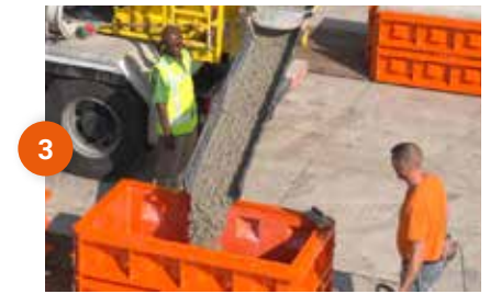
Coulage du béton
