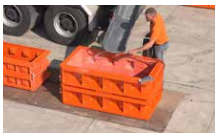
1 Placer moule sur une plaque d'acier.
