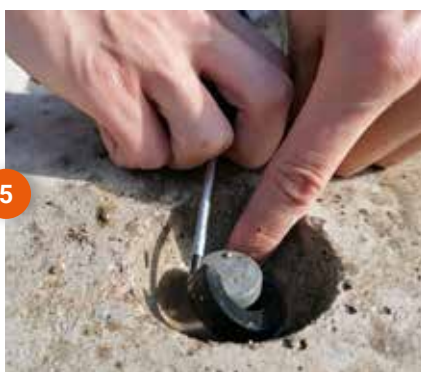
Retirez le caoutchouc de l'ancre
