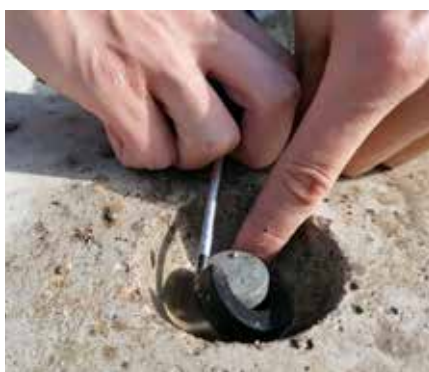
5 Retirez le caoutchouc de l'ancre
