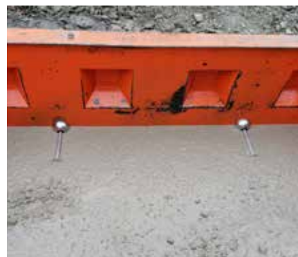
3 L'ancre est coulée dans son intégralité, attention à faire vibrer le béton
