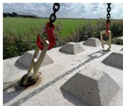
6 Fixez les crochets aux ancrages et la charge est prête à être levée
