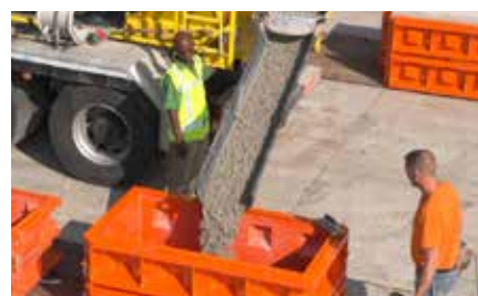
3 Coulage du béton.
