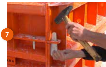
Retrait des goupilles et des clavettes
