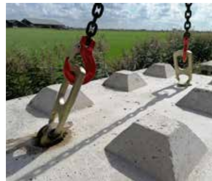
6 Fije los ganchos a los anclajes y la carga está lista para ser levantada
