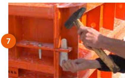
Entfernen stifte und keile
