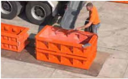
1 Forme auf einer Stahlplatte platzieren.
